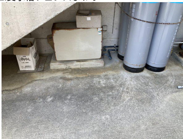
2. 受水槽フェンスまわり
