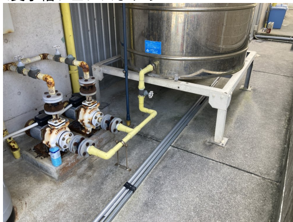
2. 受水槽フェンスまわり
